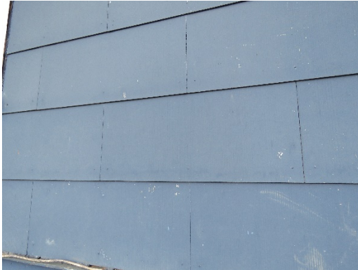
Asbestos Siding
